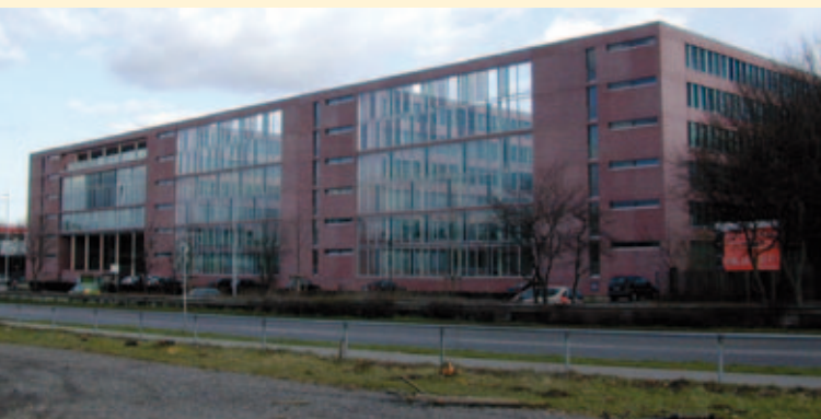
Abb. 5 Finanzamtszentrum Aachen, 30.500 m 2 BGF, 19 Zonen: Seit Februar 2011 erfolgreich mit der WVS gesteuert. Quelle: MeteoViva
