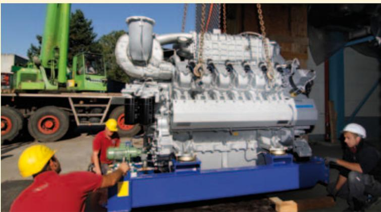
Abb. 4 Anlieferung eines 12-Zylinder Motors für das BHKW. Quelle: badenovaWÄRMEPlus
