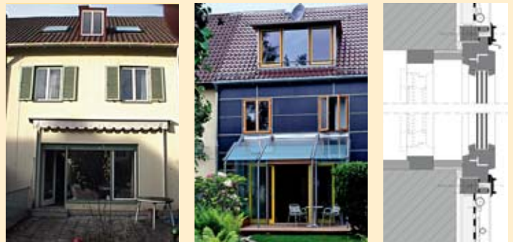
Abb. 15 Reihenhhaus, Baujahr 1956, vor der Sanierung.
