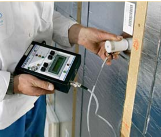
Abb. 32 Die Qualitätssicherung und -kontrolle auf der Baustelle spielt eine wichtige Rolle bei der Verwendung von VIP. Foto: HASIT
