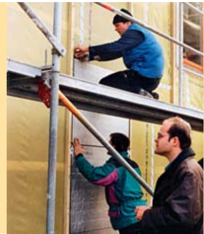
Abb. 33 Die Anordnung der VIP zwischen Holzlatten ermöglicht eine relativ einfache Montage und eine optische und haptische Kontrolle bis zur Verkleidung. Fotos: Lichtblau Architekten
