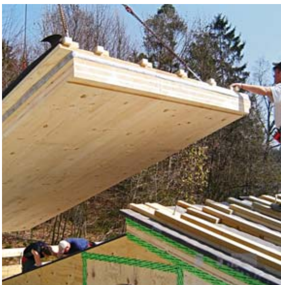
Abb. 28 Die Vorfertigung von Bauteilen im Werk bietet einen guten Schutz für die VIP. Auf der Baustelle sind solche Elemente kaum anders zu verarbeiten als konventionell gedämmte. Foto: Variotec
