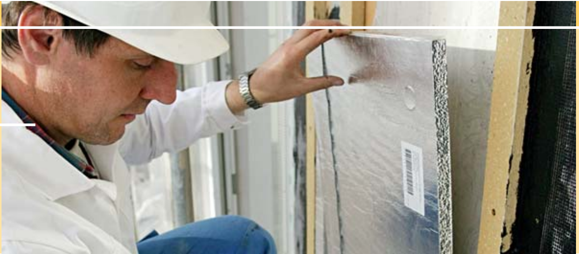
Abb. 31 Nur geschultes Personal darf die Vakuumpaneele einbauen. Foto: HASIT
