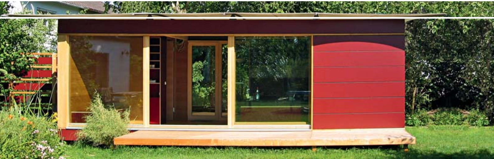
Abb. 1 Dieses Mini-Gebäude mit einer in die Sandwich-Konstruktion integrierten Vakuumdämmung zeigt den möglichen Flächengewinn: Bei nur 75 m 3 umbautem Raum wären mit einer gewöhnlichen Wärmedämmung bei gleichem Wärmeschutz nur 17 m 2 nutzbar. Foto: Dipl.-Ing. Manuela Skorka, Neuried
