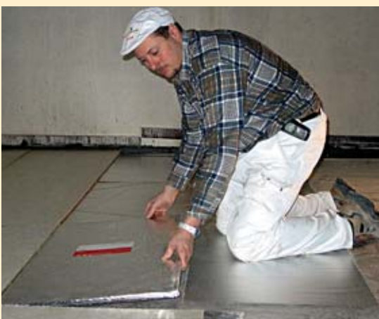
Abb. 22 VIP ermöglichen die nachträgliche Dämmung von Fußböden bei geringen Bauhöhen. Foto: Fraunhofer IBP
