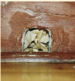
Abb. 5 Undichtigkeit in der Wandverkleidung. Quelle: Bauhaus-Universität Weimar / Anke Schenk
