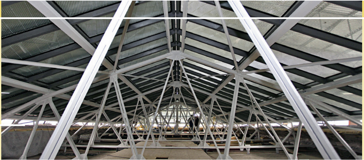
Abb. 19 Blick in die Dachkonstruktion über einer Tageslichtdecke. Die neue Spiegelrasterverglasung lässt nur diffuses Licht in die Ausstellungsräume und schützt vor Überhitzung. Quelle: Kunsthalle Mannheim / Cem Yüctas 2014
