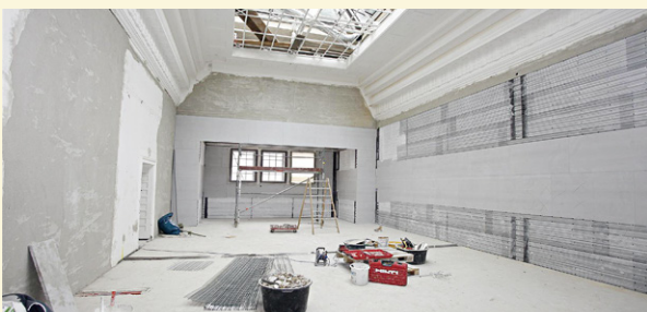
Abb. 16 Sanierung der Kunsthalle Mannheim: Die Wandheizung spart im Mittelbereich die Hängezone für Bilder aus. Quelle: Kunsthalle Mannheim / Cem Yüçetas 2014
