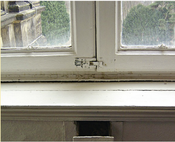
Abb. 21 Historische Fensterkonstruktion mit Vorrichtung zum Auffangen und Ableiten von Tauwasser. Quelle: Volker Huckemann
