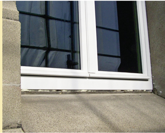
Abb. 22 Nach historischem Vorbild rekonstruiertes Fenster mit besserem Wärmeschutz. Quelle: Volker Huckemann
